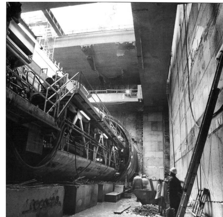
Transito della TBM "a vuoto" nelle strutture di una stazione
